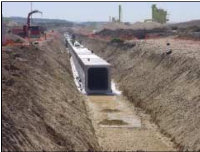
Figur 4: Bilde av en 420 kV kabelkulvert i Madrid (Foto: Statnett)
