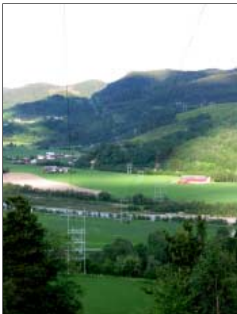
Figur 5.2: 132 kV luftledning (Foto: Tormod Eggan)
