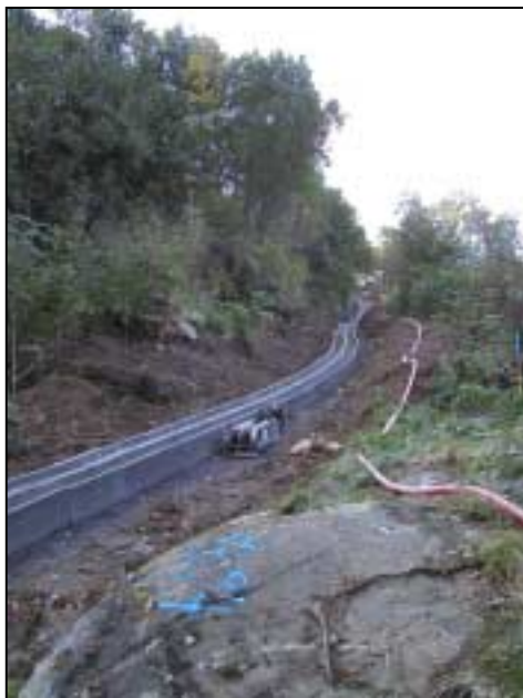
Figur 3: Det er mulig å få til anleggsarbeidet uten å benytte seg av en anleggsvei ved siden av kabelgrøften. Dette er aktuelt der terrenget gjør det umulig eller svært uheldig med en slik veg. Men dette medfører praktiske ulemper med dertil økte kostnader. Bildet viser kabelgrøft for en 132 kV kabel med to kabelsett. (Foto: BKK)
