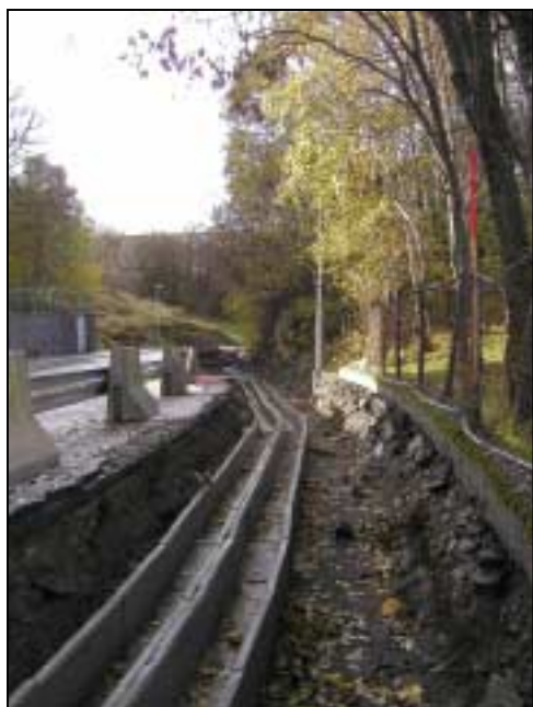
Figur 5.8: 132 kV kabelgrøft for to kabelsett lagt langs eksisterende veg. (Foto: BKK)
