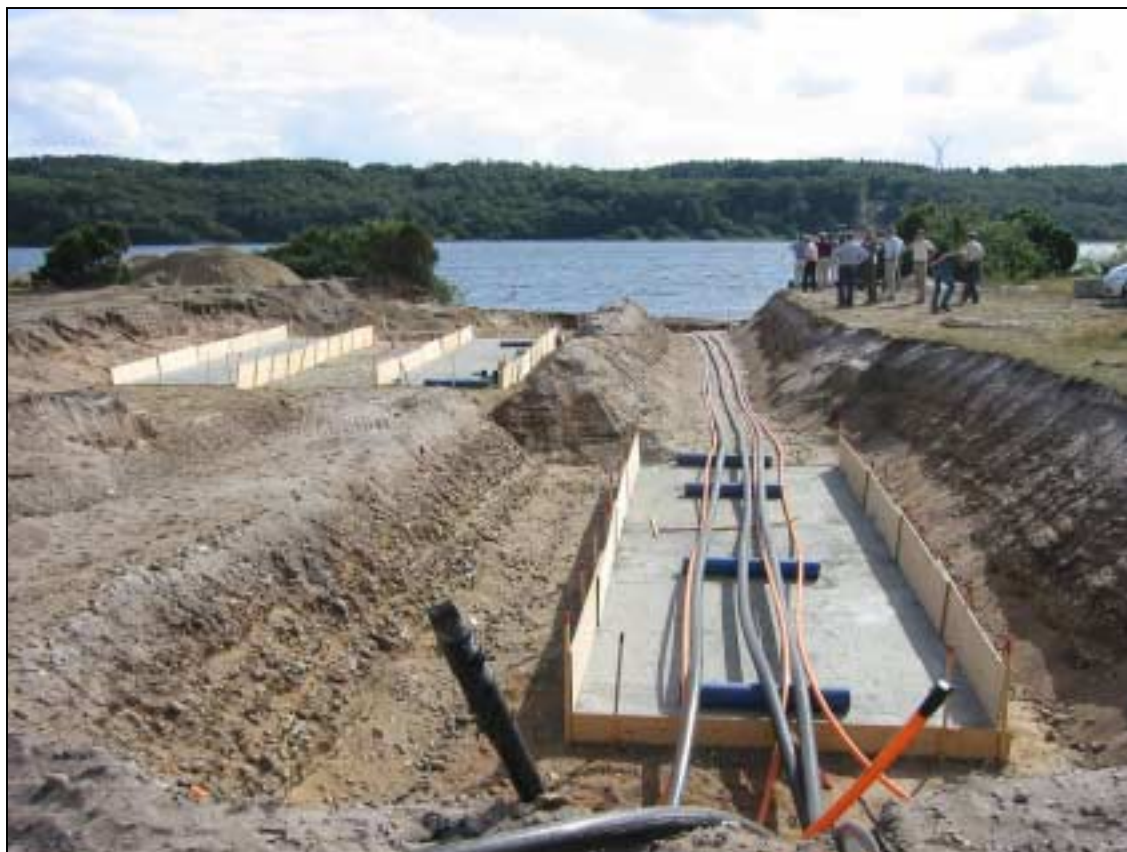
Bilde fra nettforbindelsen Katbjerg-Bramslev i Danmark. Bildet viser kabelgrøft for ett kabelsett med spenning 150 kV og to kabelsett med spenning 400 kV. Grøften har en total bredde på 20 m. (Foto: Tormod Eggan)
