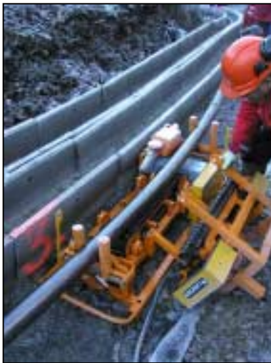
Figur 5.7: Utstyr for trekking av 132 kV kabel (Foto: BKK)
